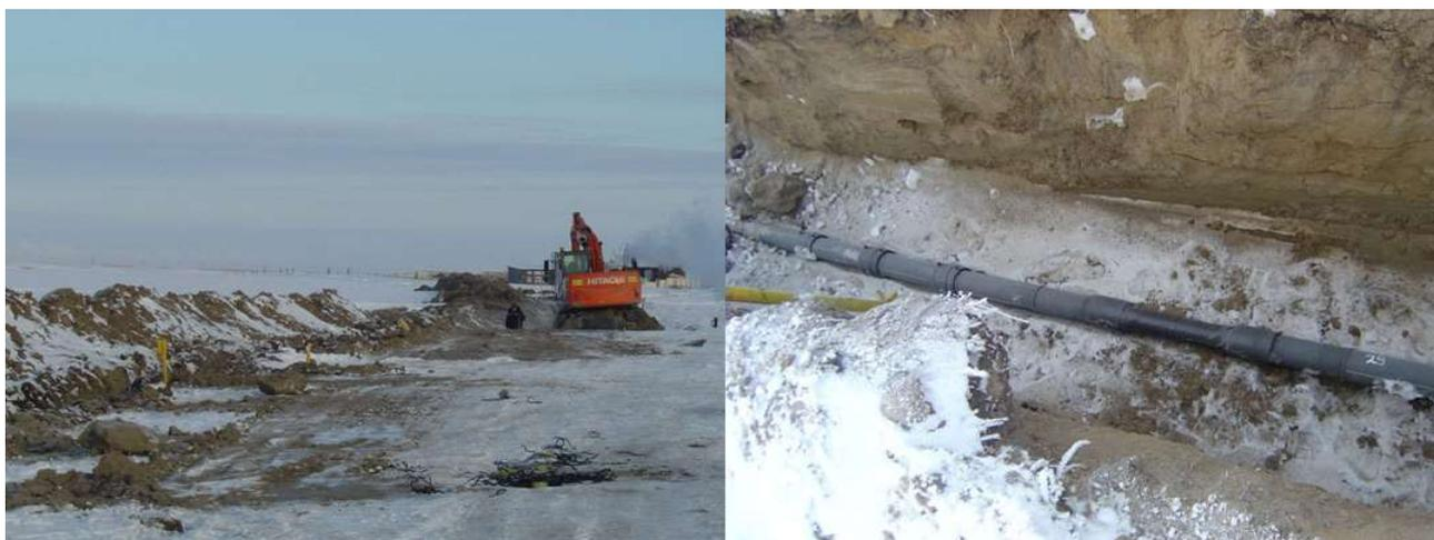
Рис.1.2 Опытно-промышленный газопровод высокого давления. с. Тулагино, г. Якутск. Ноябрь 2006 г.
