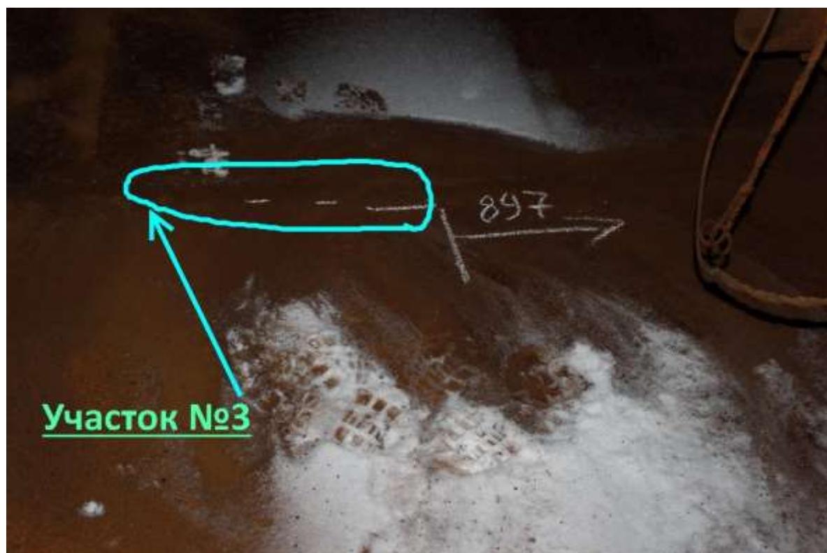
Рис. 4.15 - Участок №3, временные прихватки на основном металле
