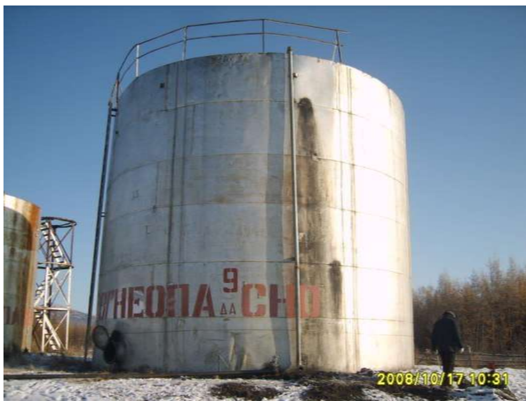
Рис. 2.14. Общего вид резервуара РВС-700 №9
