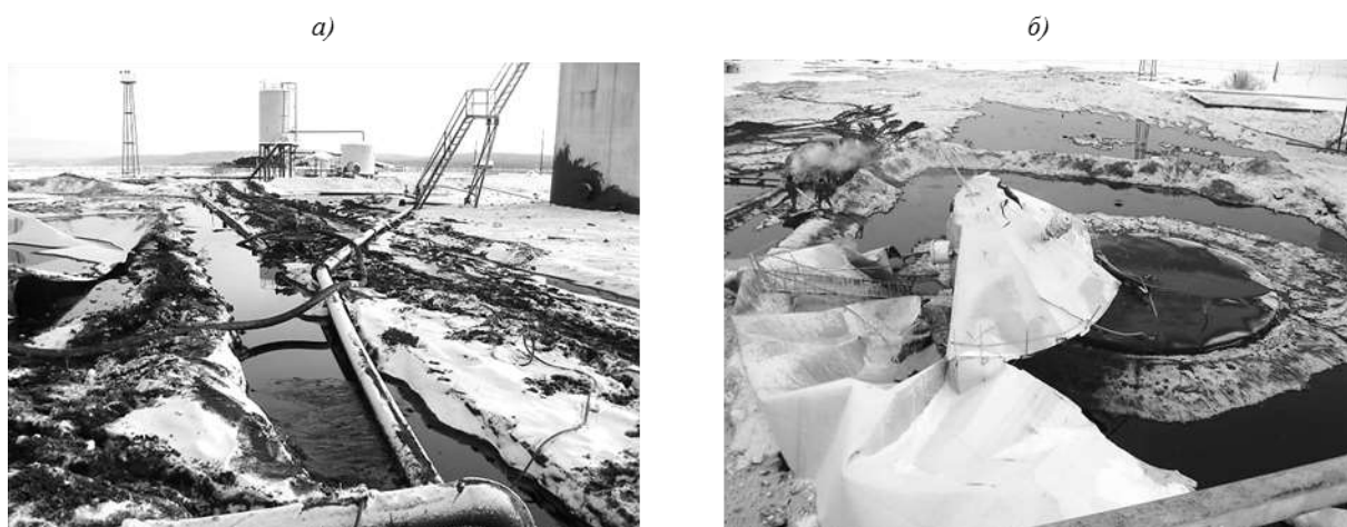
Рис. 3.14. Последствия аварии резервуара марки РВС-700 в результате хрупкого разрушения основного металла (б – вид сверху)
