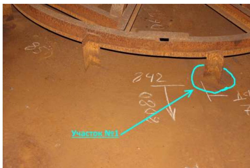
Рис. 4- Участок №1, прихватка опорного кольца центральной стойки
