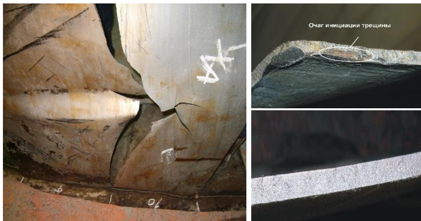
Рисунок 3 - Полное разрушение резервуара с разливом нефтепродукта
